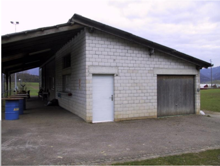
Entrée buvette et local à matériel
